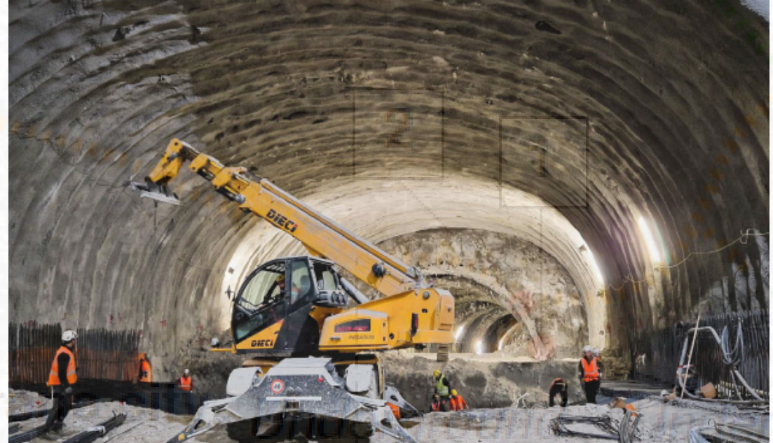
A sinistra: rotatoria in sotterraneo. Sopra: camerone a quattro corsie
