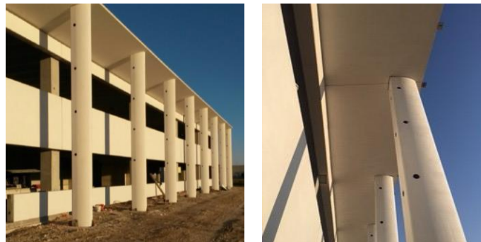
Figure 11. Installation phases of the colonnade. / Fasi di montaggio del colonnato.
