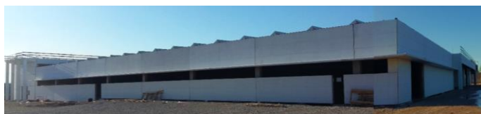
Figure 4. Mounting phases of the building and shelter. / Fasi di montaggio dell'edificio con evidenza della pensilina.
