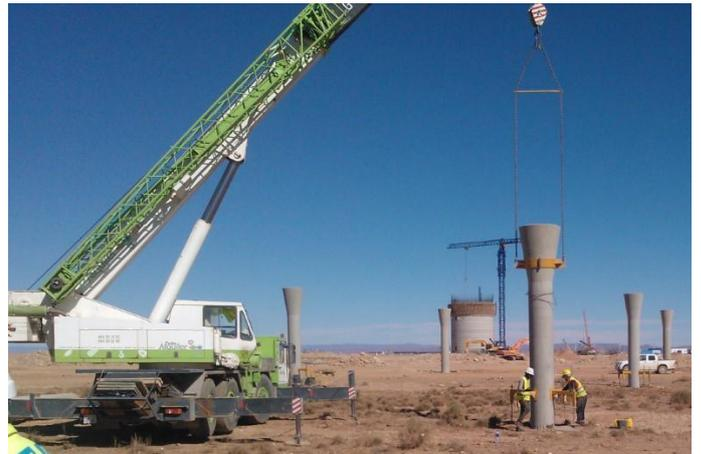
Figure 15. Assembly of the prefabricate element with telescopic crane / Montaggio dell'elemento prefabbricato tramite gru telescopica
