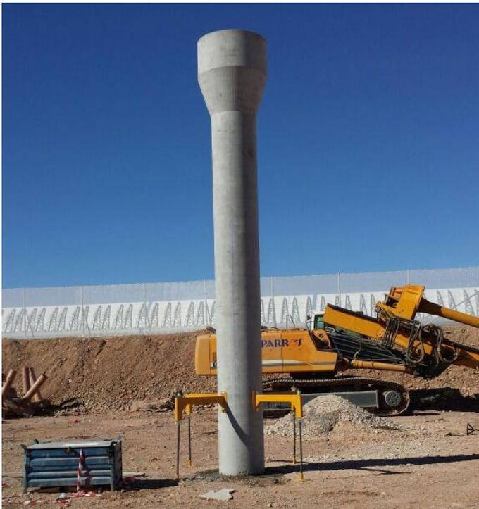
Figure 16. Metal tripod for guarantee the monolith's uprightless / Cavalletto metallico atto a garantire la verticalità del monolite
