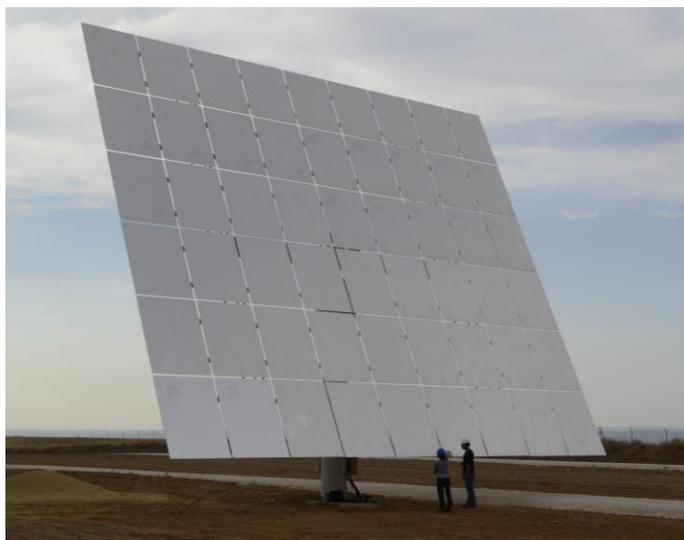
Figure 5. Solar thermal technology with mirrors which track the movement of the sun / Specchi solari utilizzati nell'impianto.
