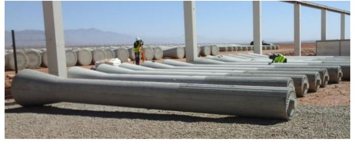
Figure 14. Dimensional check of the concrete precast elements / Controlli sui monoliti per il rispetto delle tolleranze.
