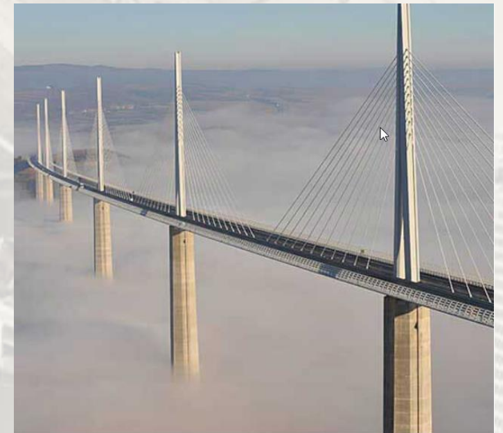
Viaduc de Millau-Eiffage/CEVM/Foster&Partners/Daniel Jamme
