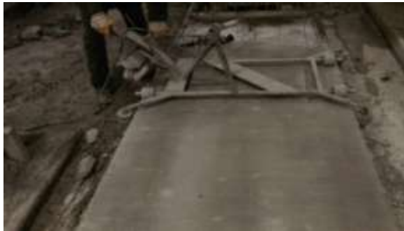
Figure 17. Saw cut of wall slabs and upper edges smoothing Taglio dei pannelli e smusso a fresa per gli spigoli a vista
