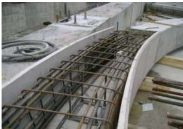
Figure 2. Armatura di connessione per assemblaggio archi Connection reinforcement for arch assembly
