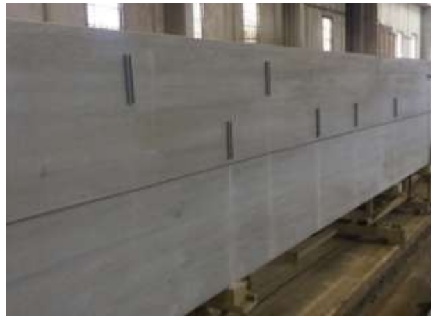
Figure 20. Inserts ready for absorbers installation Inserti posizionati per posa assorbitori acustici
