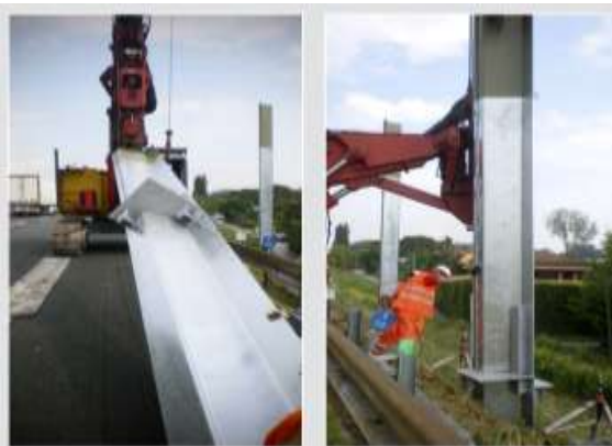
Figure 13. Specially shaped and vibro-installed plates at ground Lamiere di forma speciale vibro infissi nel terreno
