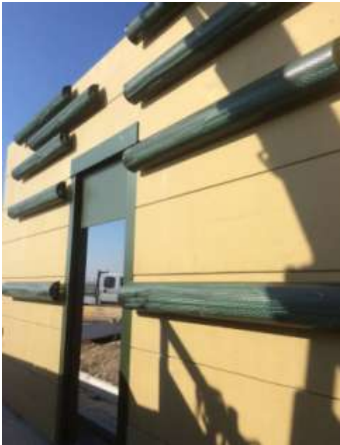
Figure 29. Door detail in the noise barrier Dettaglio di porta nella barriera
