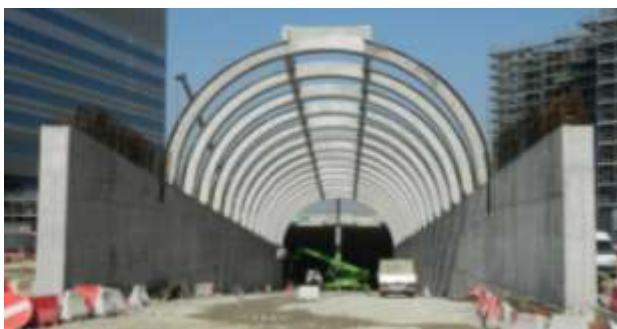
Figure 5. View of erected arch skeleton Vista della struttura ad archi posata
