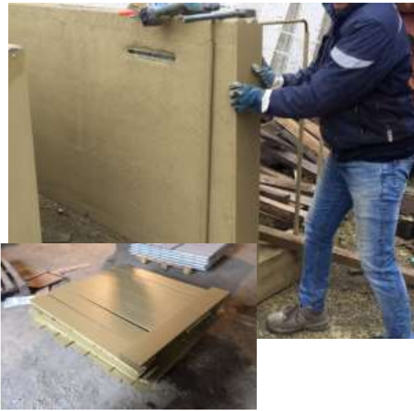
Figure 23. Steel head covers installation Installazione delle copertine di testata in acciaio
