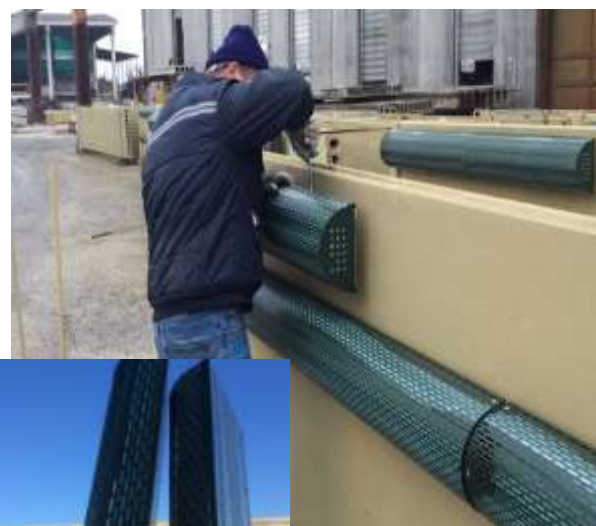
Figure 23. Steel head covers installation Installazione delle copertine di testata in acciaio
