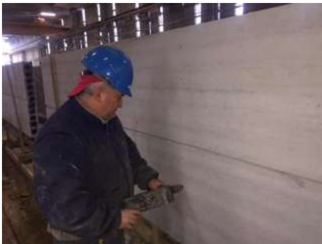
Figure 19. Drilling and positioning of inserts Foratura per posizionamento inserti
