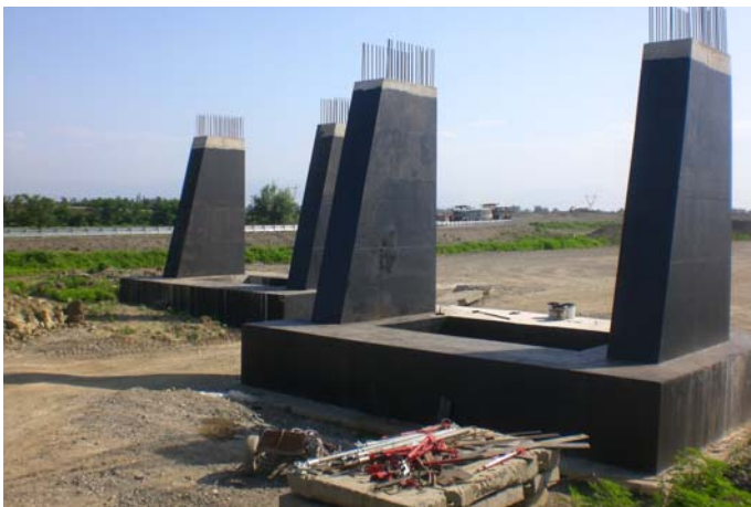
Figure 2. Column of the abutments Viaduct Pk 15/Colonne delle spalle per il Viadotto Pk 15.
