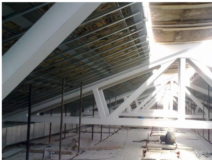
Figura 8. Dettaglio posizionamento nuovo tirante metallico/ Detail of the new tie frame
