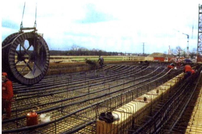
Figura 5. Installazione di cavi interni non aderenti prefabbricati Figure 5. Installation of completely prefabricated external tendons for longitudinal strengthening
