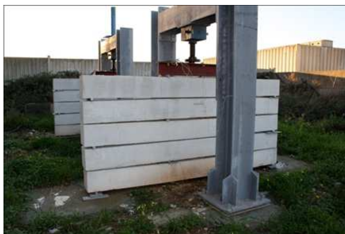
Figure 1. Loading frames on site / Telai di carico in sito.
