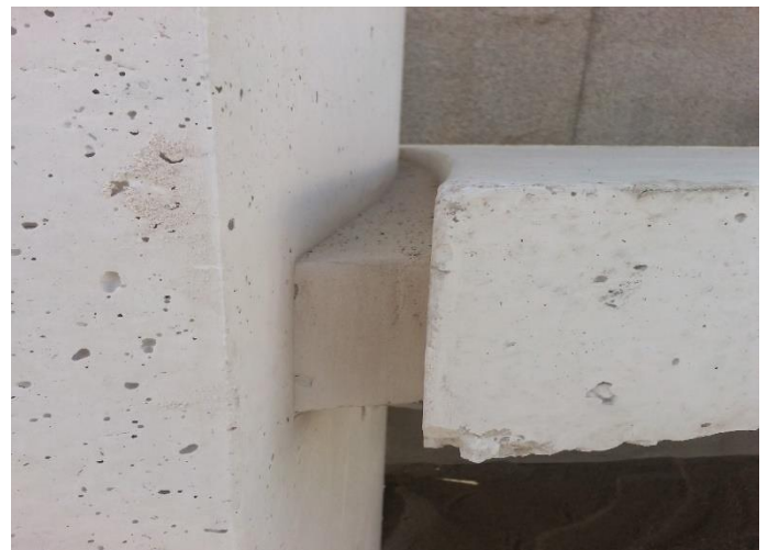
Figure 10. Detail of the panel surface / Dettaglio della finitura superficiale dei pannelli
