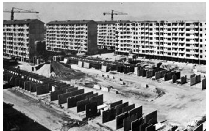
Figure 2. Baretts system. Mirafiori Sud quarter, 1st unit. Assembly phase / Sistema Baretts. Quartiere Mirafiori Sud, I nucleo. Fase di montaggio (Gescal 1966).
