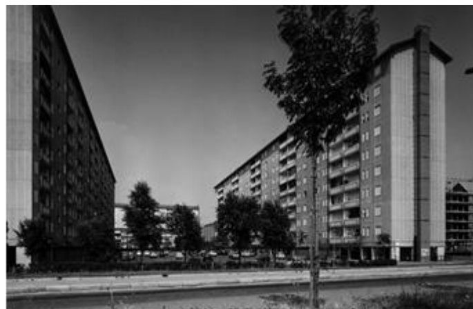
Figure 4. Co.Im.Pre.-Skarne system. Mirafiori Sud quarter, 2nd unit, 3rd lot. General view / Sistema Co.Im.Pre.-Skarne. Quartiere Mirafiori Sud, II nucleo, 3° lotto. Veduta del complesso (Foto Moncalvo, ABCAT, Fondo Dolza, MS).
