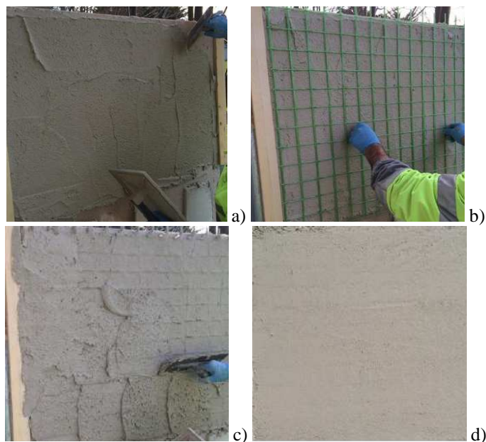
Figure 8. Reinforced plastering application / Prova di applicazione di intonaco rinforzato.
